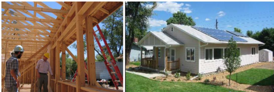
תרשים 13: מבנה מאופס אנרגיה בדנוור, קולורדו. משמאל, מערכת קיר כפולה (חיצונית ופנימית) עם מרווח המיועד לבידוד. הבידוד בין שני חלקי הקיר מונע את הגשרים התרמיים.
